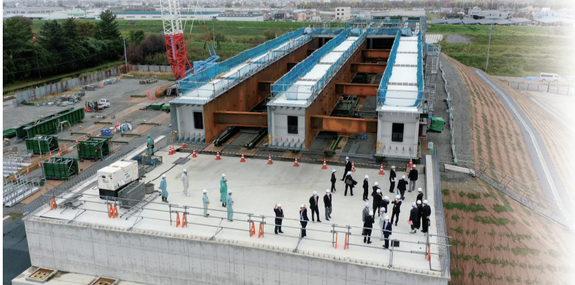
新山梨環状道路東部区間II期工事(甲府市落合町現場)
